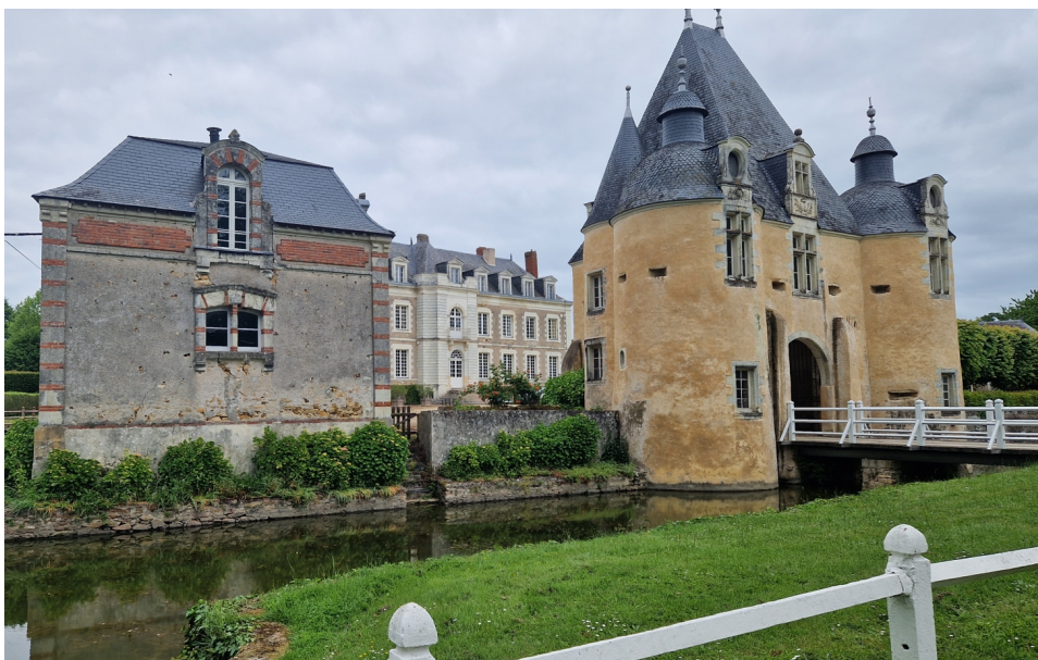
Le château avec son châtelet au premier plan (photo du BRAC)
